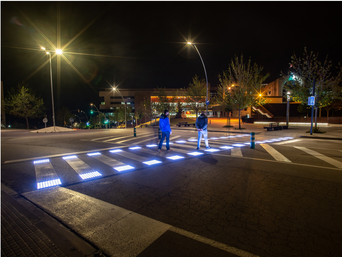
Pas de vianants davant de l'Hospital de Sant Joan de Déu, amb sensors de moviment i il·luminació led.
